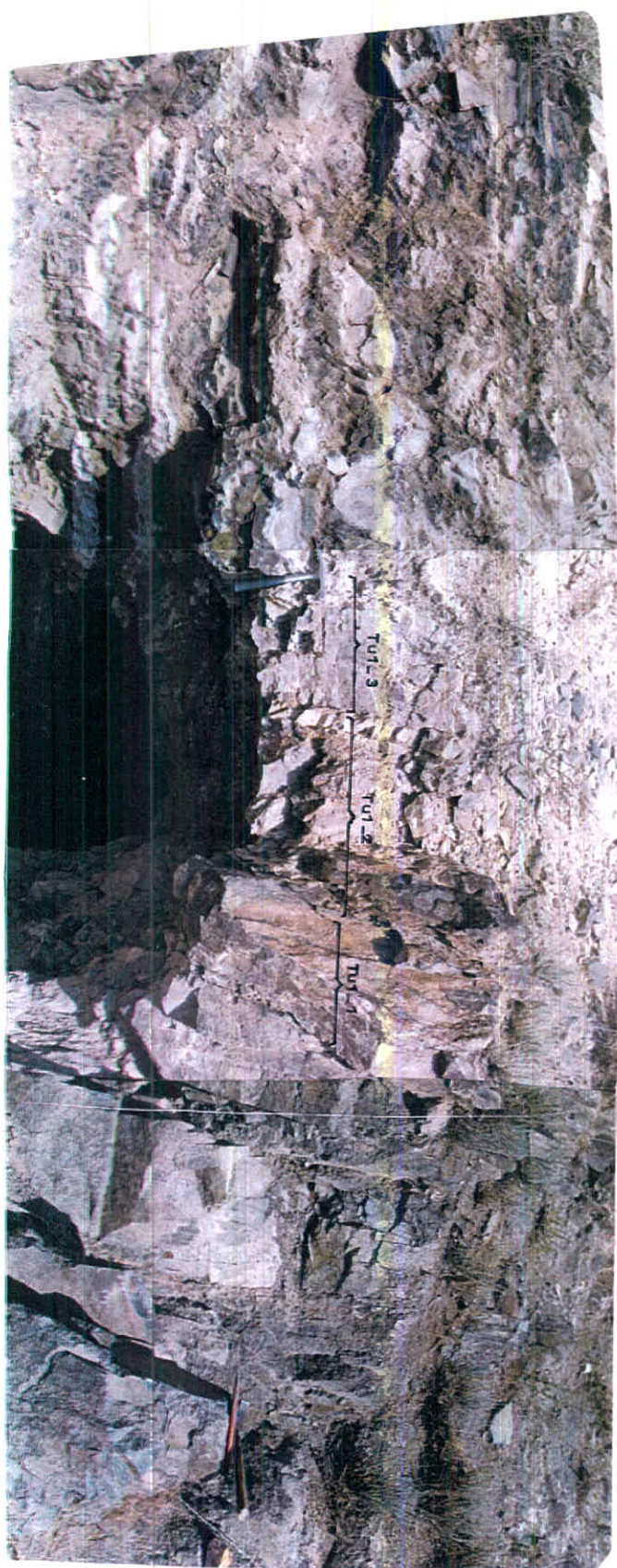
تصویر شماره ۱۳ - دهانه تونل TU1 - سنگهای گرانیتی در سمت راست، زون خرد شده در سقف تونل و سنگهای دگرگرفته در سمت چپ مشخص اند.
