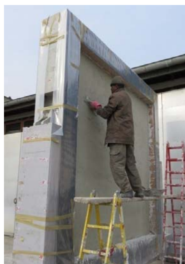
۲-۳ دیوار در حین و بعد از اجرای ملات اندودکاری سبک و عایق حرارتی
