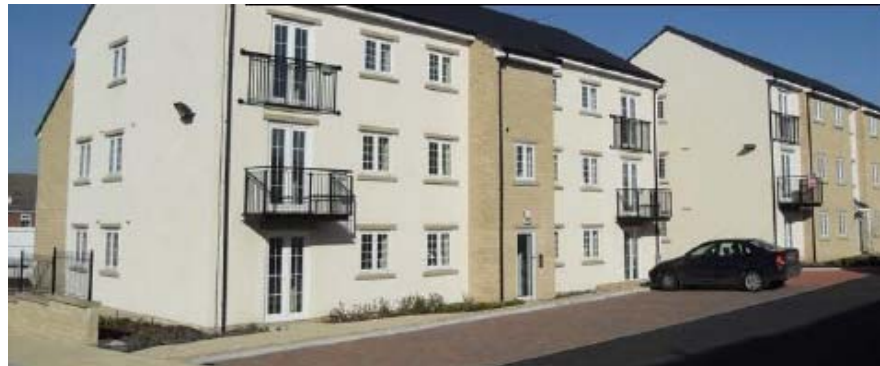
شکل ۱-۷- ساختمان با نمای پلیمری
