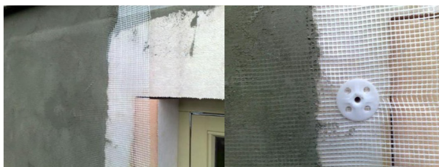
شکل ۱-۹- نمونه‌ای از مش تقویت کننده در اجرای اندودکاری
