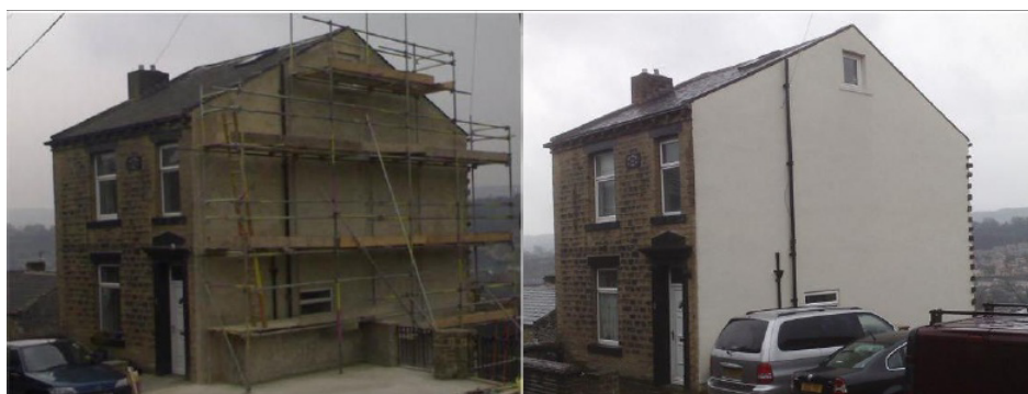
شکل ۱-۴ اندودکاری یک ساختمان پیش و پس از اجرا
