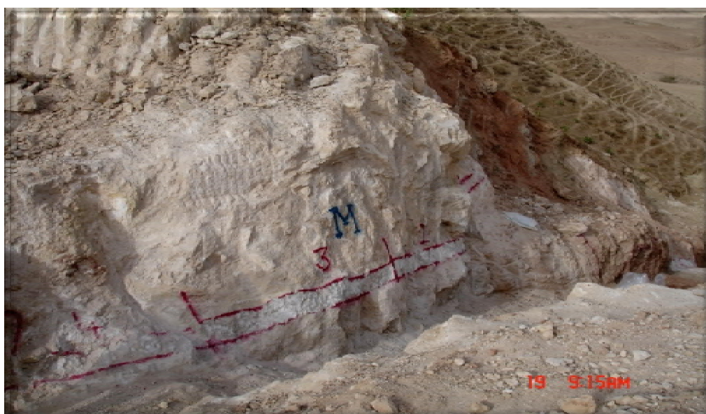
تصویر 3-8: نمایی از پیشکار اکتشافی در لایه ی سنگ گچ [M] واقع در ترانشه ی شماره 1 [T1]. (دید به سوی جنوب باختر).
