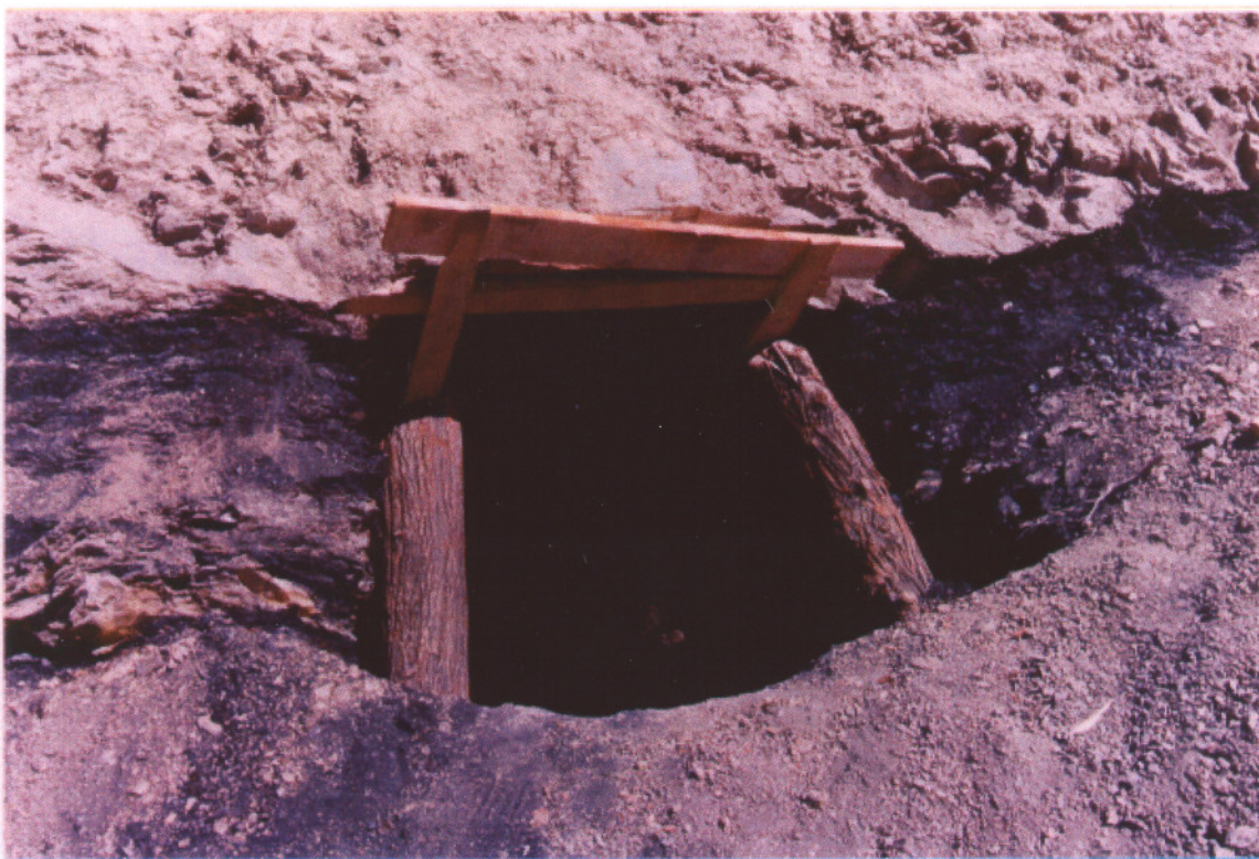
تونل برناکی ذغال سنگ طرزه که به صورت دو اکلن روی لایه های K طراحی شده است. اکلن یک در حال بهره برداری و اکلن ۲ در حال آماده سازی می باشد.
