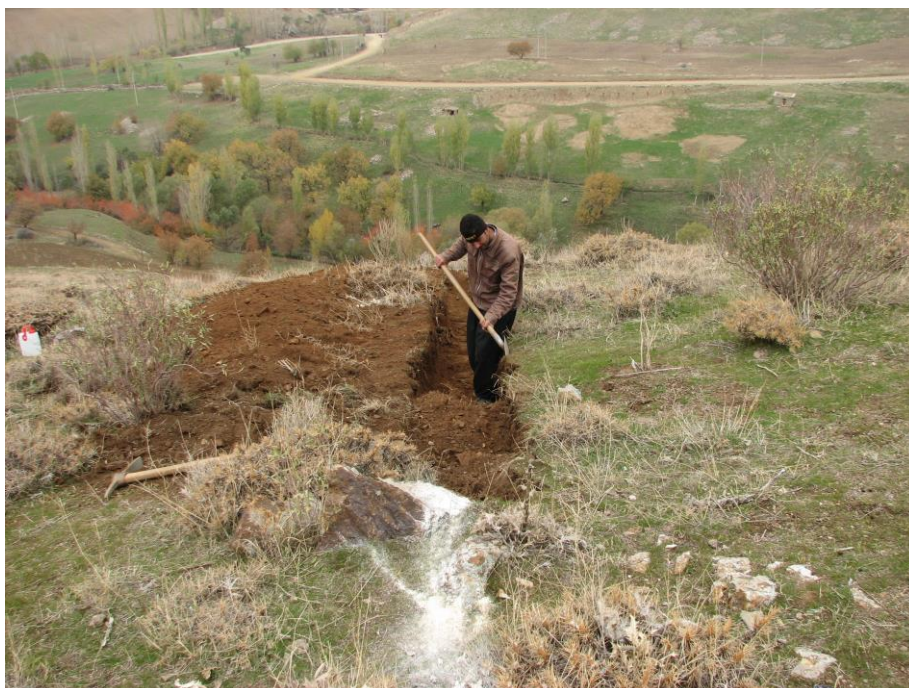
تصویر 3: عملیات حفر ترانشه در محدوده اکتشافی قبغلوچه جنوبی
