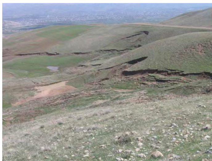
شکل ۵-۷ زمین لغزش تحریک شده در اثر رویداد زمین لرزه در جاده بروجرد به کولیدر (پژوهشگاه بین‌المللی زلزله‌شناسی و مهندسی زلزله)
