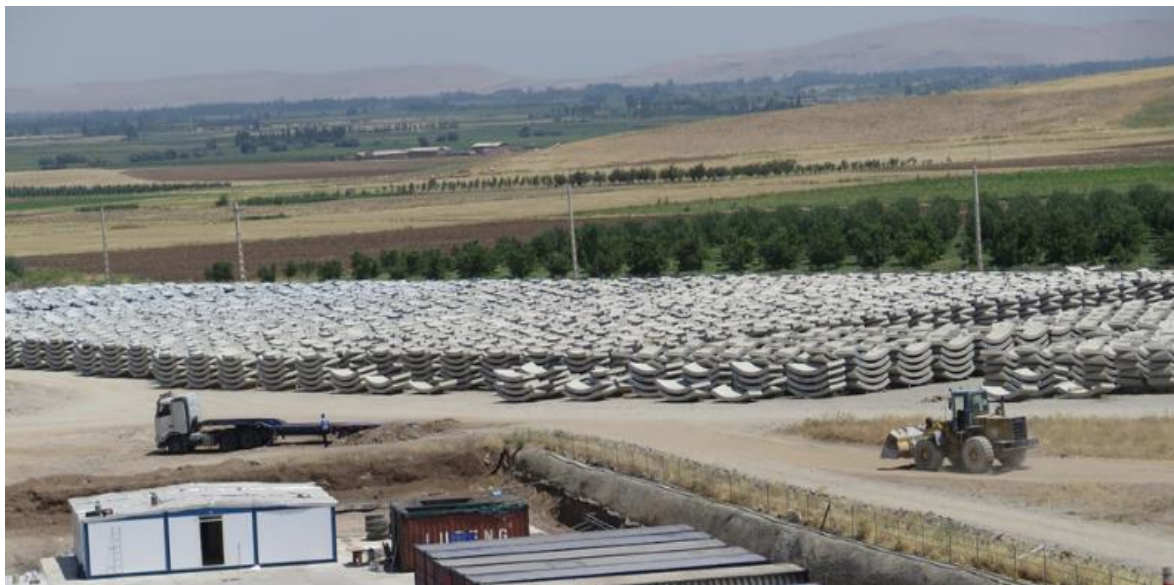
شکل ۱۹- تولید و دپو سگمنت‌های مورد نیاز تونل انتقال آب در محل کارگاه عملیات اجرایی
