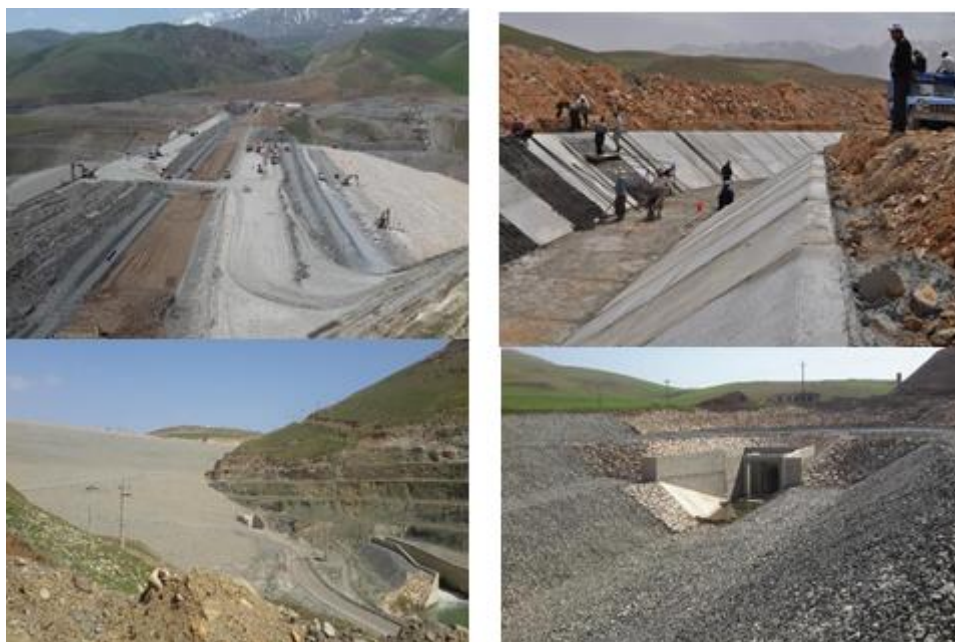
شکل ۲۱- آخرین وضعیت اجرایی سد سیلوه و کانال انتقال آب جلدیان
