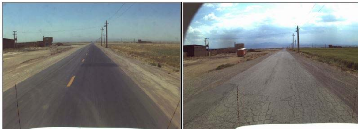
شکل ۴- تصویر قبل و بعد عملیات بهسازی کیلومتر ۱+۲۰۰ محور RQ-05 به عنوان نمونه
